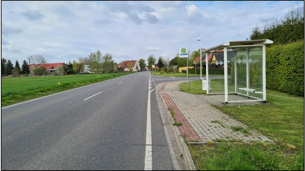
Bild 3: Haltestelle, östlich der Einmündung Rietweg (Blick in westliche Richtung)
